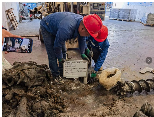
图 7.2-5 填砾及止水（现场照片）
