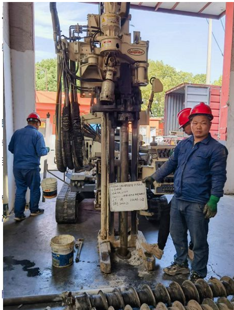
图 7.2-3 钻孔（现场照片）
